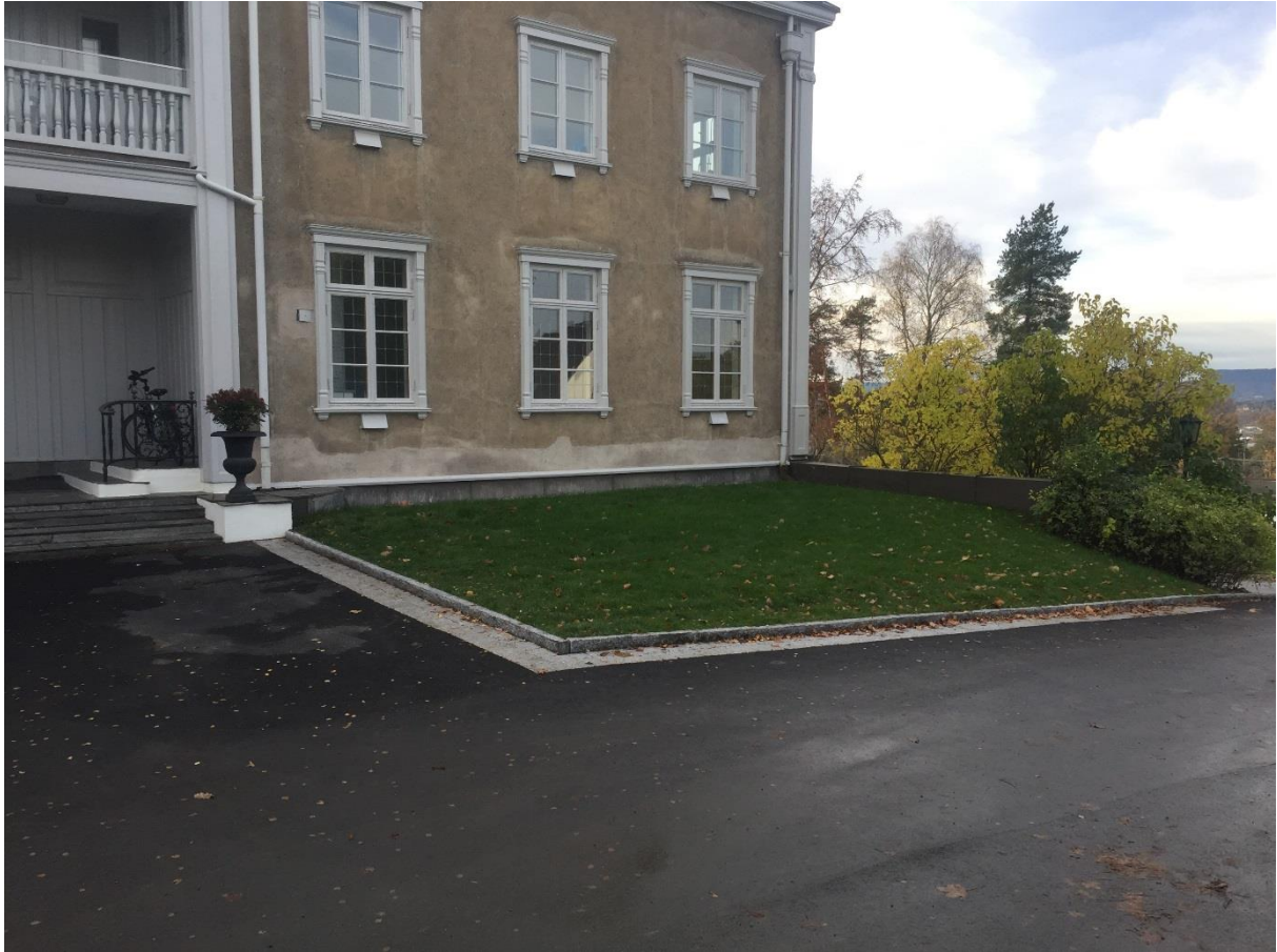
Hovedbygget – nytt asfaltdekke lagt ifm rehabilitering 2018.
