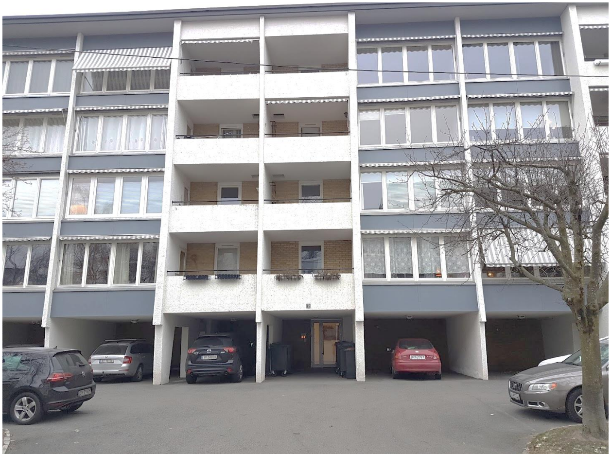
Dagens situasjon i Solhaugveien 83, hovedinngang. Avfallskontainere foran inngangsdøren.
