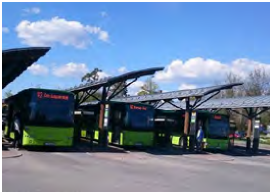
Kollektivknutepunkt på Bekkestua
