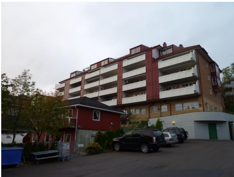
Foran eksisterende barnehage i Jernbaneveien 11. Tomten sett mot NV og Gml. Drammensvei 44
