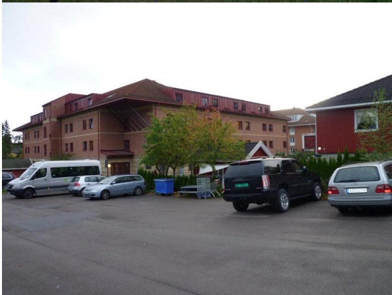
Foran eksisterende barnehage. Tomten sett mot syd og Stabekktunet bo- og behandlingssenter
