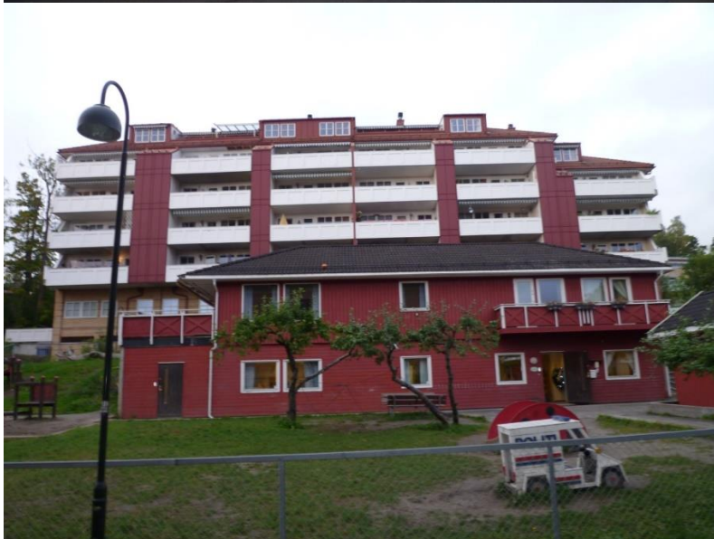
Eksisterende barnehage. med Gml. Drammensvei 44 i bakgrunnen.
