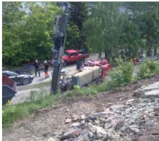
Figur 4: Boring av energibrønn
