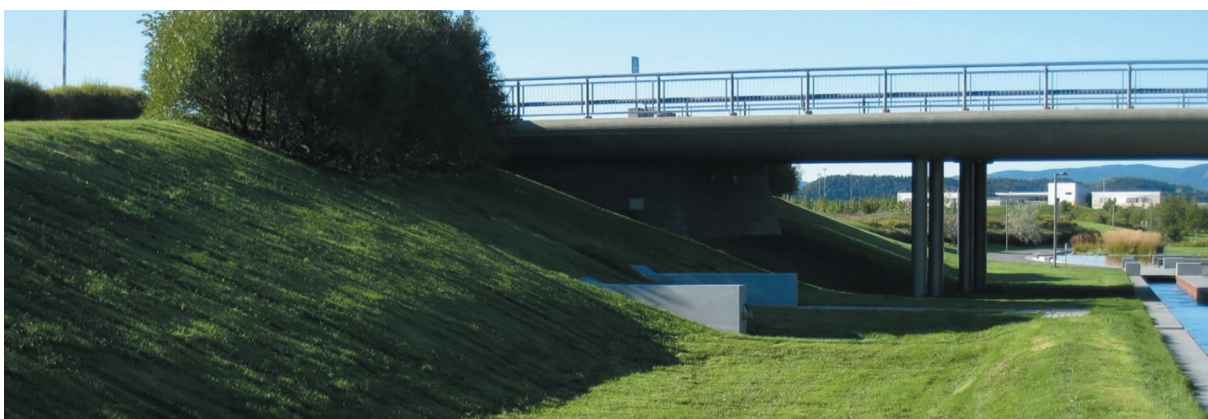
Figur 5-4: Eksempel på sentralt blågrønt areal i park utformet for magasinerings, infiltrasjon og rensing av overvann fra vei på Fornebu. Overvann fra en lengre veistrekning ledes til dammen. Innløpet er lagt i steininstallasjonen nær brua (Foto: SVV/Ane Kirstine Laukli).
