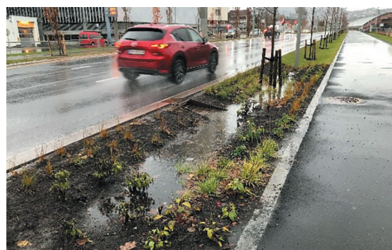
Figur 5-5: Eksempel på langsgående blågrønn løsning (nedsenket grøntrabatt/regnbed) i gate der overvannet fra veibane/GS-vei infiltreres og renses i rabatten. Bjørnstjerne Bjørnsons gate i Drammen, fotoet til høyre er tatt etter et kraftig regnvær (Foto: SVV/Ane Kirstine Laukli).
