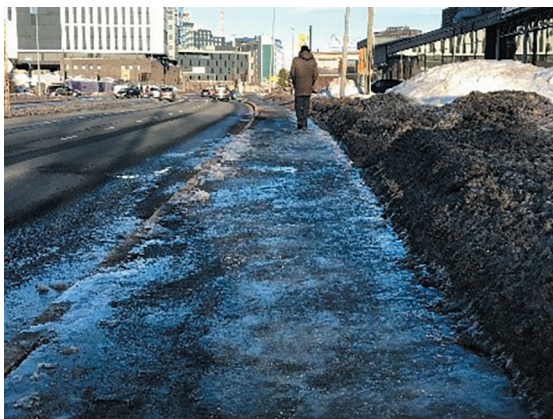
Figur 5-12: Ved anlegg for gående og syklende kan kryssende smelte vann føre til glatte overflater i perioder med vekslende tining og frysing. (Foto. COWI).
