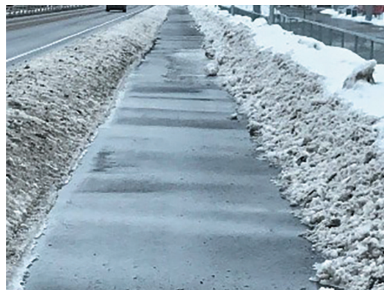
Figur 5-12: Ved anlegg for gående og syklende kan kryssende smelte vann føre til glatte overflater i perioder med vekslende tining og frysing. (Foto. COWI).
