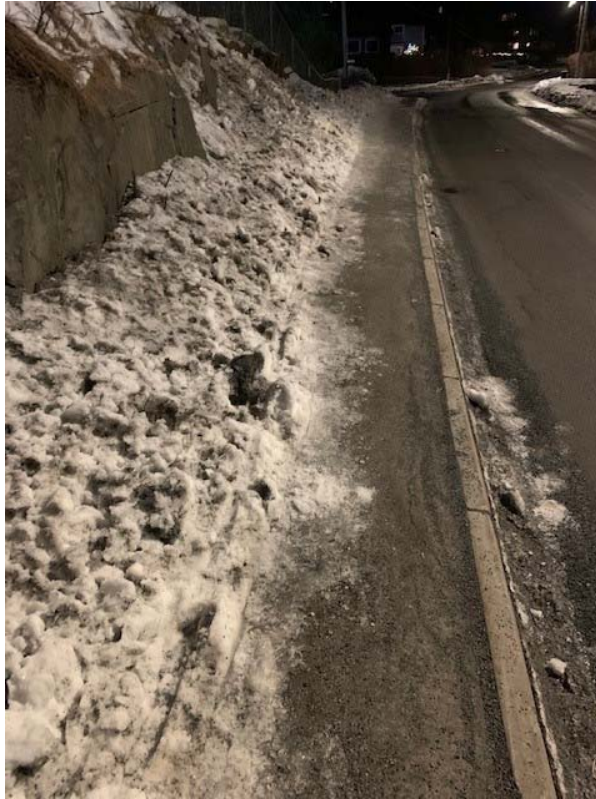
Figur: Smale fortau uten snølagringsareal skaper utfordringer for myke trafikanter vinterstid (bildet er fra Wilhelm Wilhelmsens vei på Hosle)
