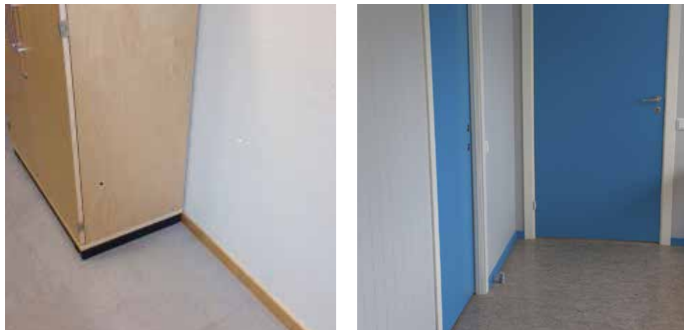
Demensvennlige eksempler på gulvlist som skaper skille mellom gulv og vegg
