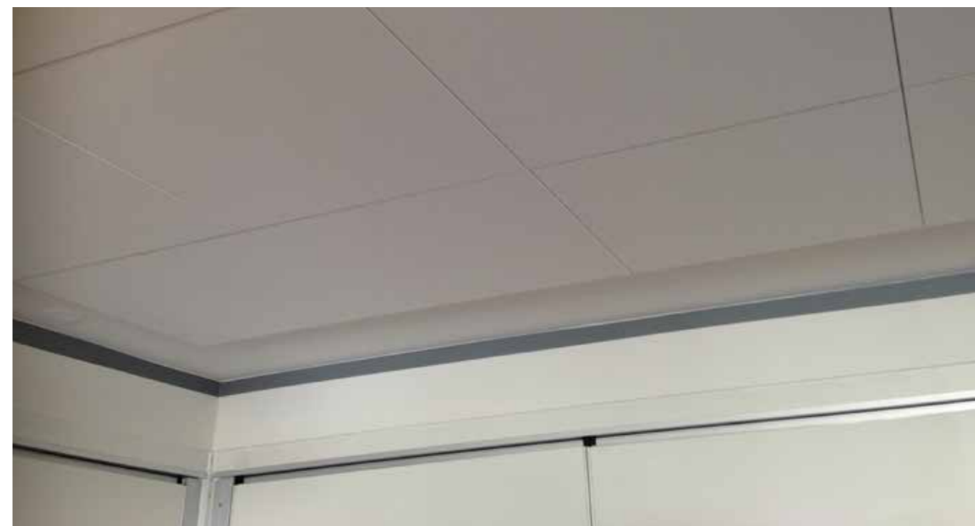
Eksempel på ettermonterte akustikkplater og malt list i taket for å skape kontrast mellom tak og vegg
