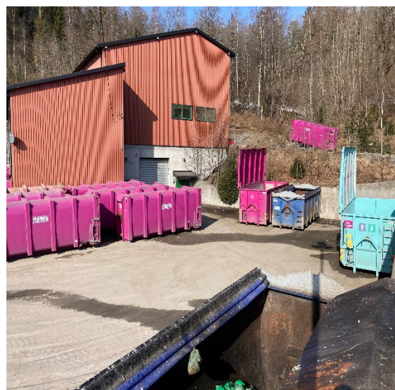
Figur 2: Omlastestasjon med rampe og containere hvor matavfall omlastes direkte til containere i forgrunnen
