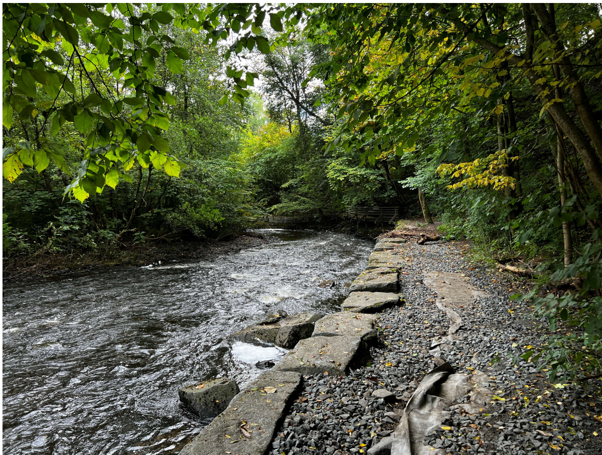
Figur 2-10 Turveitraseen sør for Jarfossen er en av strekningene som har blitt betydelig rustet opp de senere årene. Likevel har deler av toppdekket blitt vasket vekk etter de store nedbørmengdene høsten 2023. Foto: Markus Strand.
