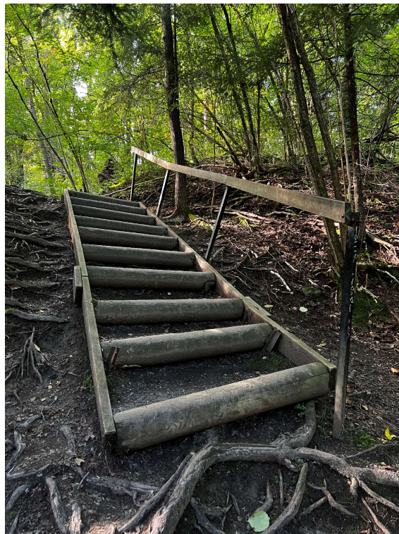
Figur 2-6 Trappa sør for Jarfyllinga er noe ujevn og har et vinglete rekkverk. Foto: Markus Strand.
