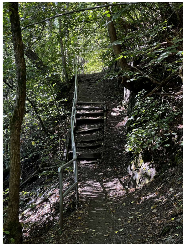
Figur 2-11 Bygde konstruksjoner forfaller i større grad enn det øvrige stinettet. I tillegg kan konstruksjonene i seg selv utgjøre en sikkerhetsrisiko. Legg merke til den bratte skrenten under trappa til venstre. Foto: Markus Strand.
