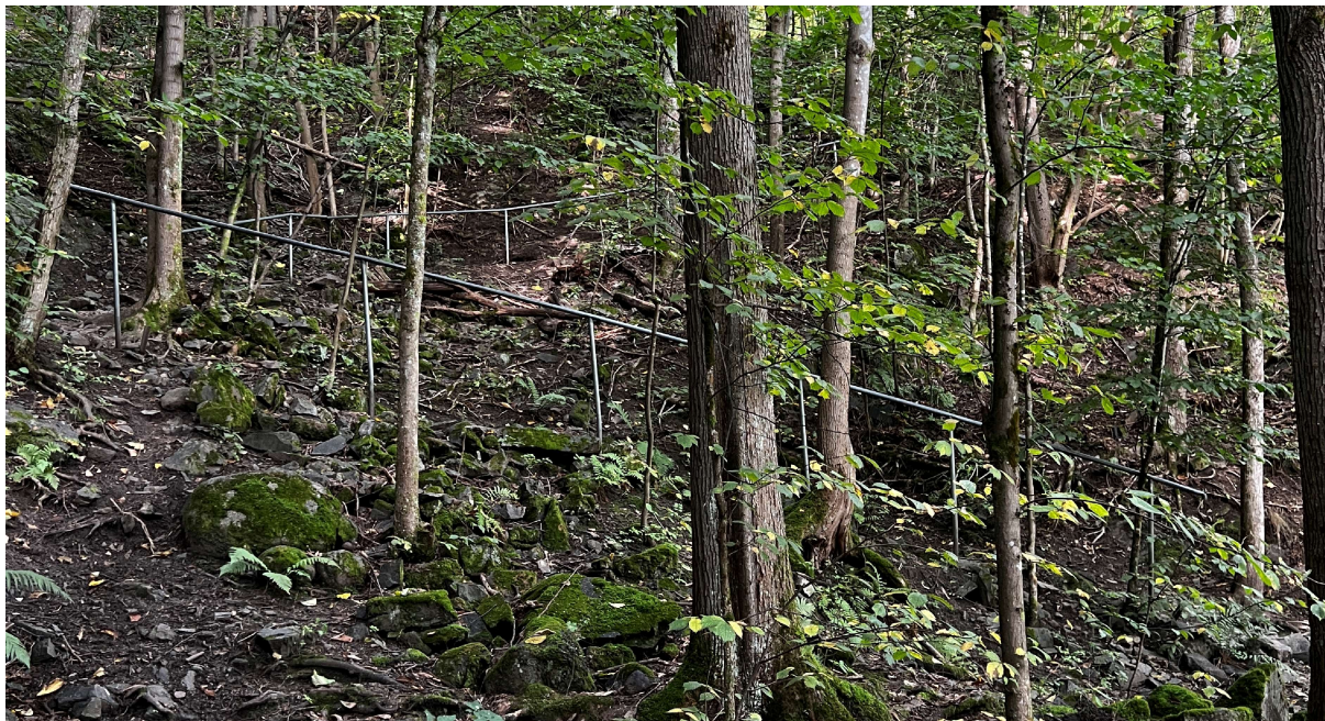
Figur 2-8 Opp forbi Jarfossen er det akkurat plass til en smal sti. Denne høydeforseringen er en av strekningene med størst stigning langs hovedtraseen. Foto: Markus Strand.
