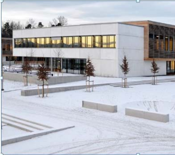
Fig. 16 På Hundsund skole er det vektlagt tekniske løsninger mht. energibehov og varmegjenvinning. (Foto: Bærum kommune)
