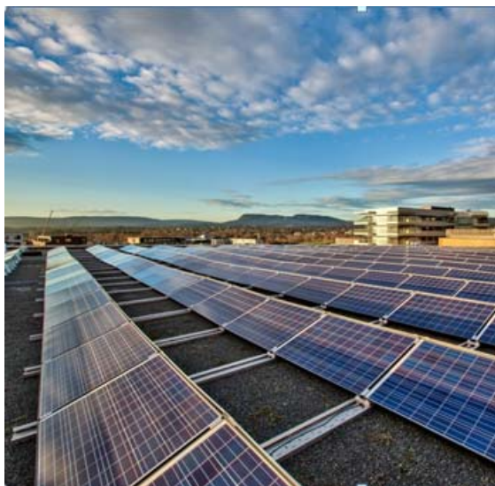
Fig. 8 Solcellepanel fra taket på kjøpesenteret Fornebu S, som er et passivhus. (Foto: Fornebu S)
