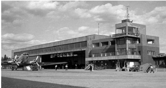
Terminalbygning i tegl, tårn i betong og verkstedbygning i tegl som ble bygget rundt hangaren i korrugerte (bølgete) stålplater. Bygget under krigen, (1940-1945). Foto: Digitalt museum.
