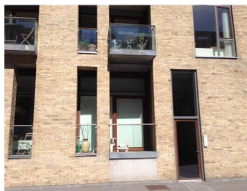
Eksempel på løftet førsteetasje mot gate.
