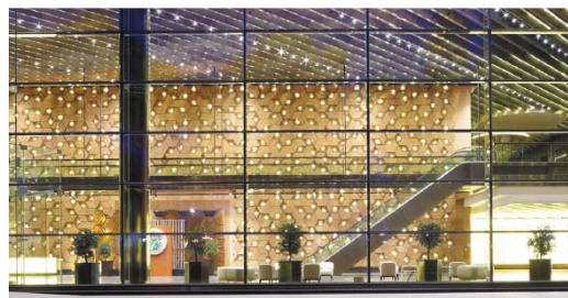
Åpen fasade med lobby
