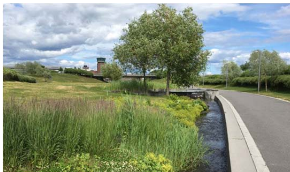
Overvannsrenne langs hovedgrøntdraget i Nansenparken (foto: Bjørbekk & Lindheim).
