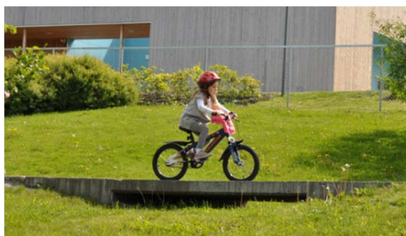
Små klopper etableres der gangveiene krysser over overvannsrennen.
