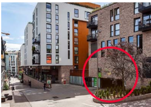
Innkjøring til parkeringsanlegg i et bymessig område, arealeffektiv og godt integrert i bebyggelsen. Fra Vulkanområdet i Oslo.
