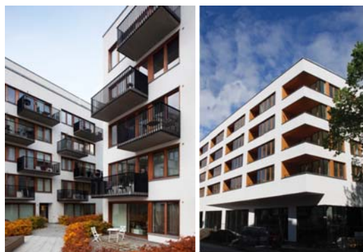
Prosjektet Lille Bislett, Oslo, viser at variasjon også kan oppnås ved lik bruk av materialitet og farger, ved å ha ulike balkongutforming og plassering får bygget et variert uttrykk med få virkemidler. Tegnet av Dyrvik arkitekter.
