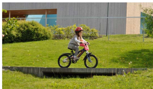
Små klopper etableres der gangveiene krysser over overvannsrennene
