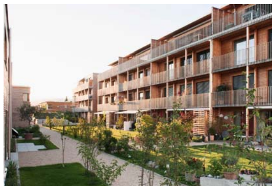
Boligområdet «Sunny Watt», Sveits, arkitekt Beat Kämpfen-Federer. Planlagt for både sosial, miljømessig og økonomisk bærekraft. Massivhusprosjekt og tilnærmet null-energihus. Består av prefabrikerte tak og vegger. Kombinerer bruk av solenergi og geotermisk energi.
