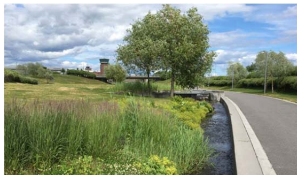
Overvannsrenne langs hovedgrøntdraget i Nansenparken (foto: Bjørbeek & Lindheim)
