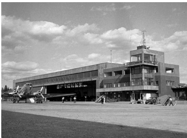
Terminalbygning i tegl, tårn i betong og verksted-bygning i tegl som ble bygget rundt hangaren i korrugerte (bølgete) stålplater. Bygget under krigen, (1940-1945). Foto: Digitalt museum.
