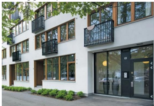
Lille Bislett – boligkvartal med åpen fasade og inngang mot gate (Kilde: Dyrvik arkitekter)
