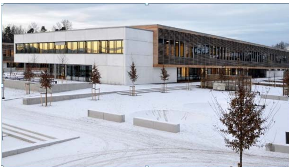
Ved Hundsund grendesenter er det vektlagt tekniske løsninger mht energibehov og varmegjenvinning.
