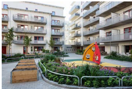
Bostadsbolaget, Kv Gräslöken
