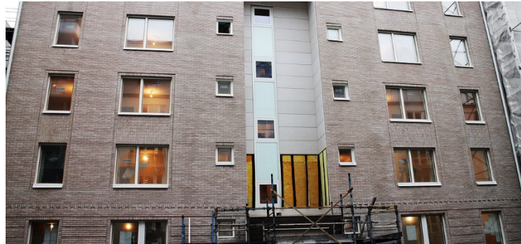
NCC, Kv Pärllöken
