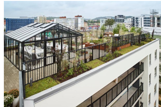
Veidekke, Kv Klätterträdet
