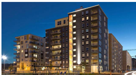
NCC, Kv Silverlöken
