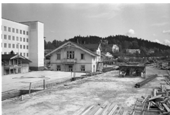
Bygging av E-18 forbi Sandvika, Bærum. (Tidl. Riksvei 40). Fotografert 1964.
