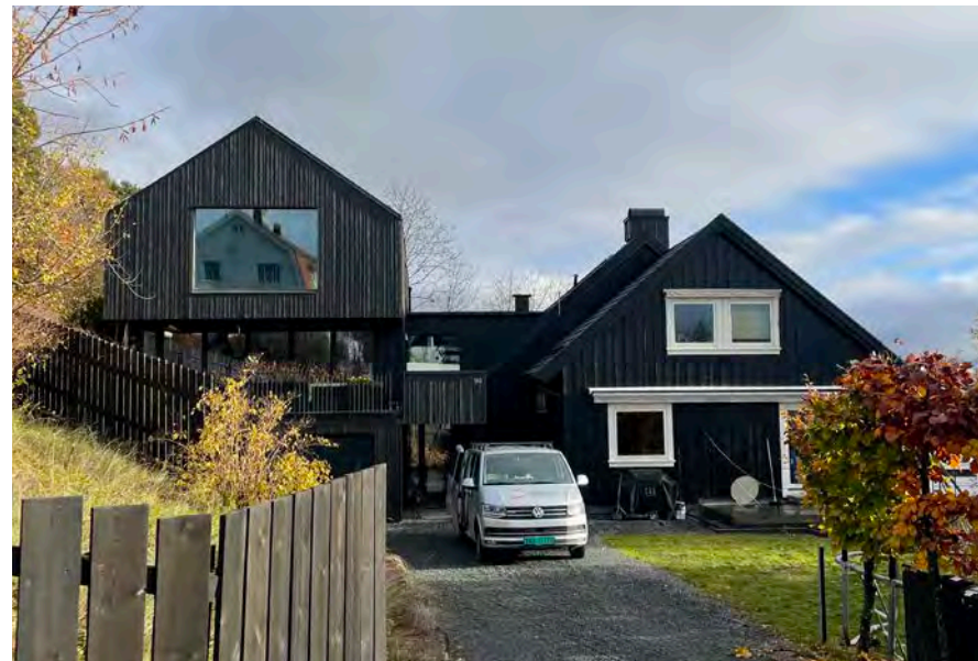
Ramstadåsveien 9 A - eksempel på tilpasset tilbygg, vertikaldelt tomannsbolig.
