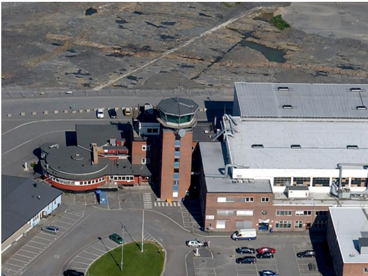
Utsnitt av Gamle Fornebu ca. 1953. Det gamle kontrolltårnet har fått kontrollrom i glass på toppen av bygget.
