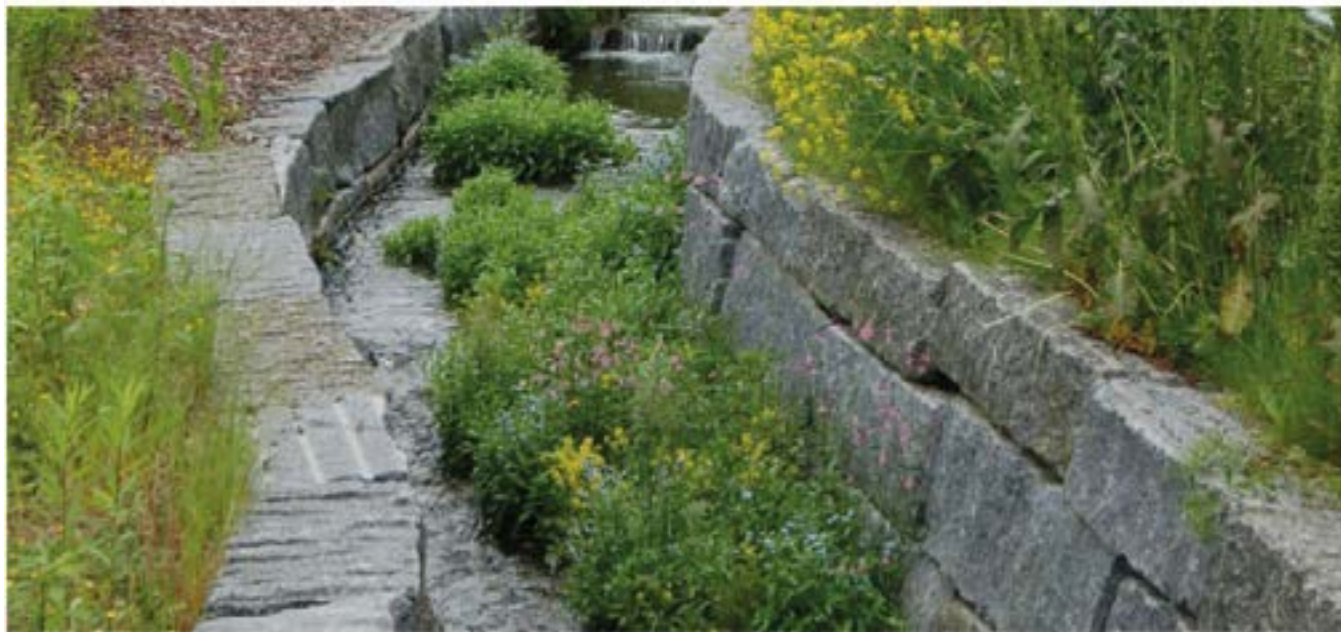
Åpning Solbergbekken, Handlingsplan overvann, Bærum kommune
