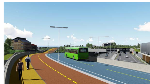
Figur 17: Bru over E18 fra Tjernsmyr mot Oksenøyveien.
