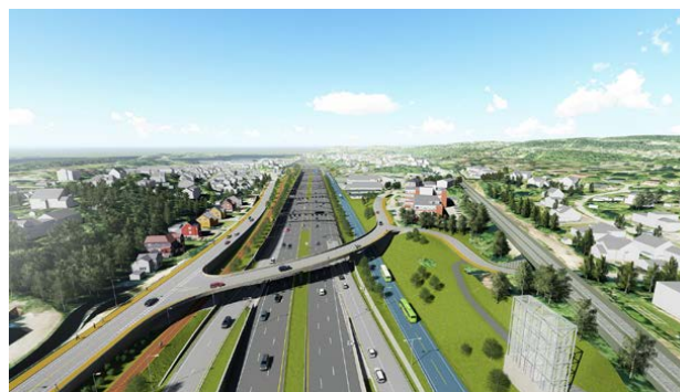
Figur 41: E18 sett vestover fra Høvik mot Ramstadsletta. Luftetårn til høyre
