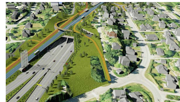
Figur 31: Portal for Bærumsdiagonalen i senter og lokalveg til/fra Høvik på hver side under miljølokket på Strand. Kjørefelt fra Bærumsdiagonalen og lokalvegen flettes sammen og føres til E18 ved NC-bygget. I vestgående retning er feltbruken tilsvarende fra E18.
