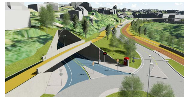
Figur 13: Gang-/sykkelbru over kileformet portal ved Prof. Kohts vei sett fra vest.
