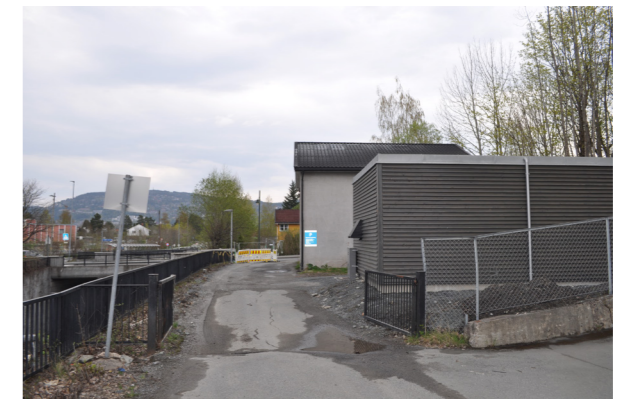
Dagens innkjørsel kantes av en likeretter og en trafostasjon. Grunnet teknologisk utvikling kan trafoen på ca. 30m 2 erstatte dagens virksomhet i telesentralen.
