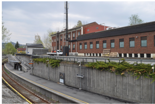
Telesentralen ligger rett over t-bane stasjonen på Eiksmarka.
