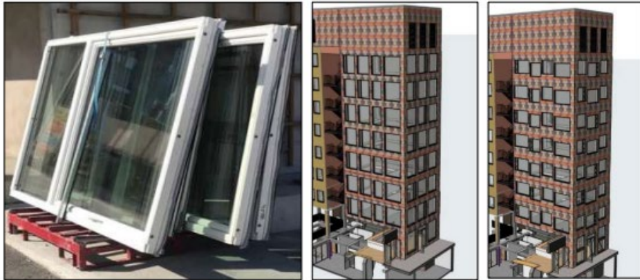
Vinduer demontert fra et boligprosjekt i Kværnerbyen. Foto: Resirqel Fasade tilbygg, prosjektet med 1) Nye vinduer, 2) Brukte vinduer. Illustrasjoner: Mad arkitekter
