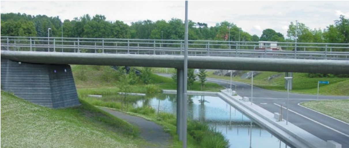
Figur 5-3: Eksempel på en sentral åpen dam for fordøyning og rensing av overvann fra vei på Fornebu. Overvann fra en lengre veistrekning ledes til dammen (Foto: COWI).
