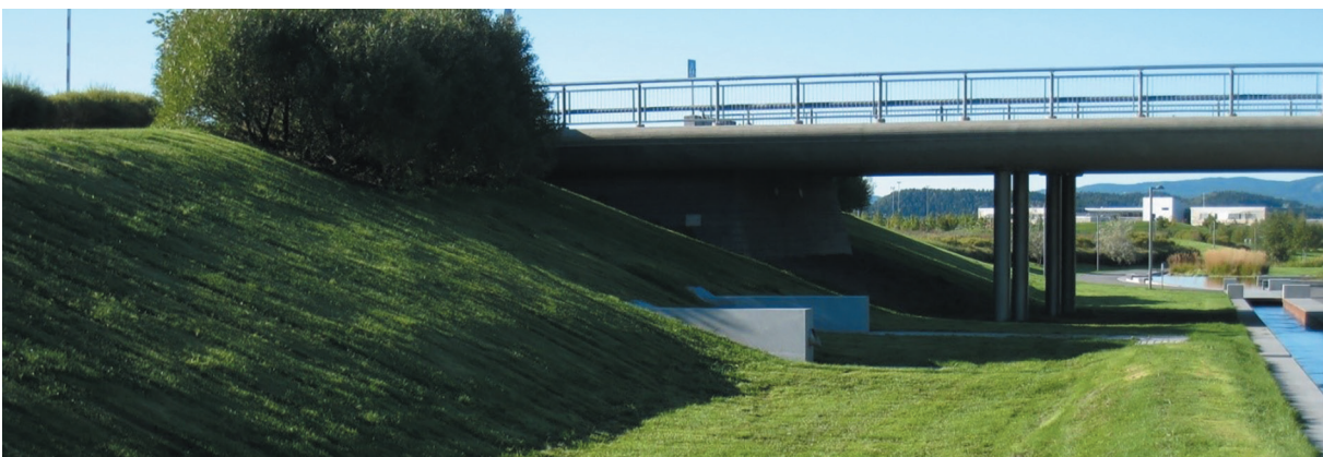
Figur 5-4: Eksempel på sentralt blågrønt areal i park utformet for magasinerings, infiltrasjon og rensing av overvann fra vei på Fornebu. Overvann fra en lengre veistrekning ledes til dammen. Innløpet er lagt i steininstallasjonen nær brua (Foto: SVV).
